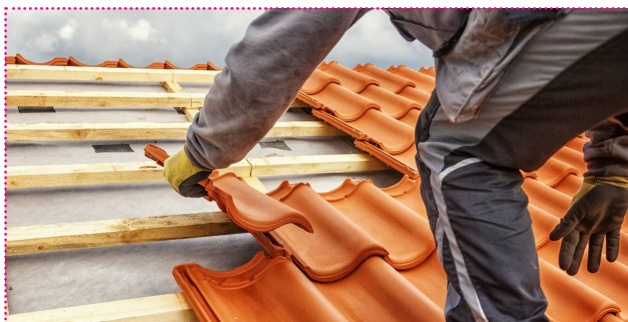
COUVREUR : Pose et réparation des toitures.
