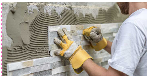
CARRELEUR-MOSAÏSTE : Revêtement des sols et murs avec des carreaux.
