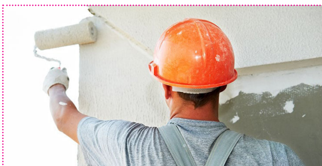
PEINTRE EN BÂTIMENT : Application de peintures et revêtements.
