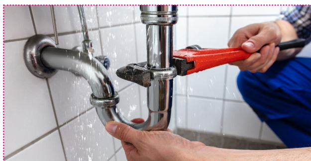
PLOMBIER : Installation et maintenance des systèmes de plomberie
