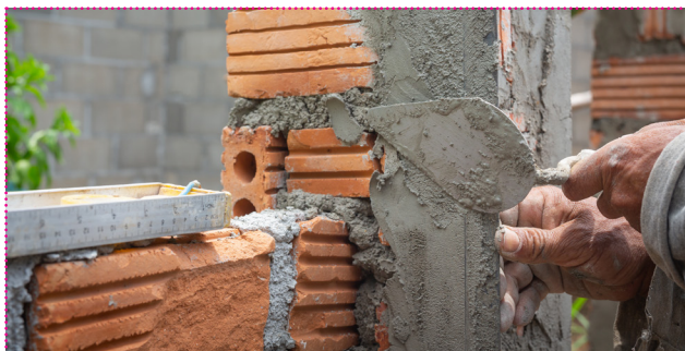
MAÇON : Construction des murs, fondations et structures.
