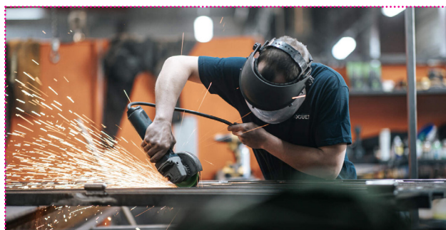
SERRURIER-MÉTALLIER : Fabrication et pose d'ouvrages métalliques.
